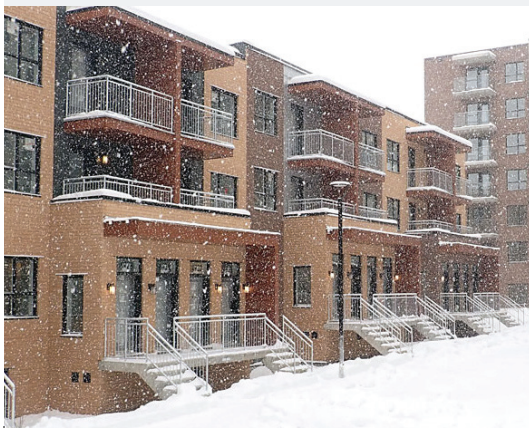
La COOP de Solidarité Les voisins Viau-Robert 197 logements
