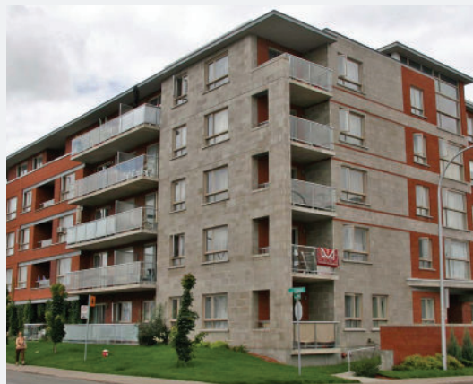
La COOP Château Dignité 47 logements
